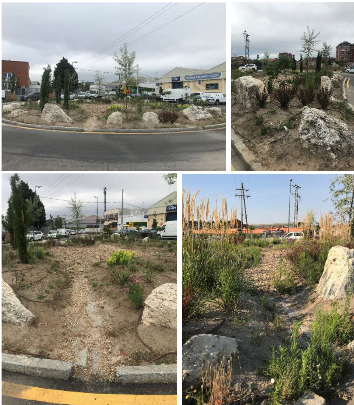
Fig. 56, 57, 58 y 59. Fotografías del jardín de lluvia de la rotonda de la calle Pilar Miró, polígono de Argales, Valladolid, 56 - 58 hechas en mayo y 59 hecha en julio, de 2022. Fuente: M. Rosario del Caz Enjuto (UVa).
