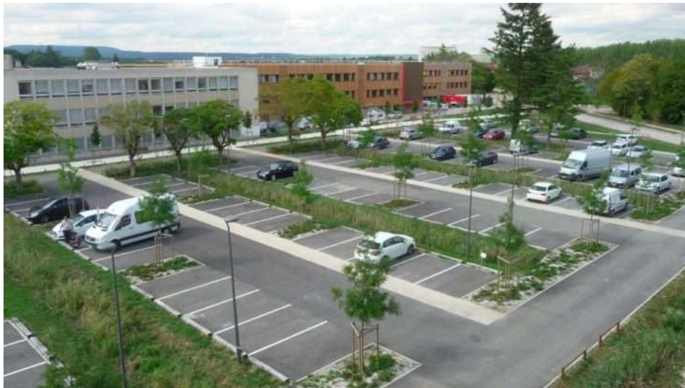
Fig. 25. Aparcamiento en TAE Techonopole, Bretenière Côte d'Or, Borgoña, Francia. Fuente: https://www.mayottoussaint.fr/portfolio/breteniere-tae-technopole-agro-environmental/
