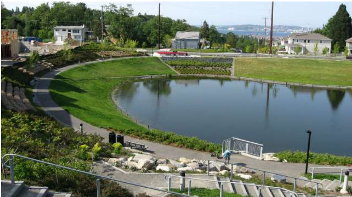
Fig. 21. Estanque de retención. Fuente: Sudsostenible, http://sudsostenible.com/tipologia-de-las-tecnicas/medidas-estructurales/estanques-de-retencion/
