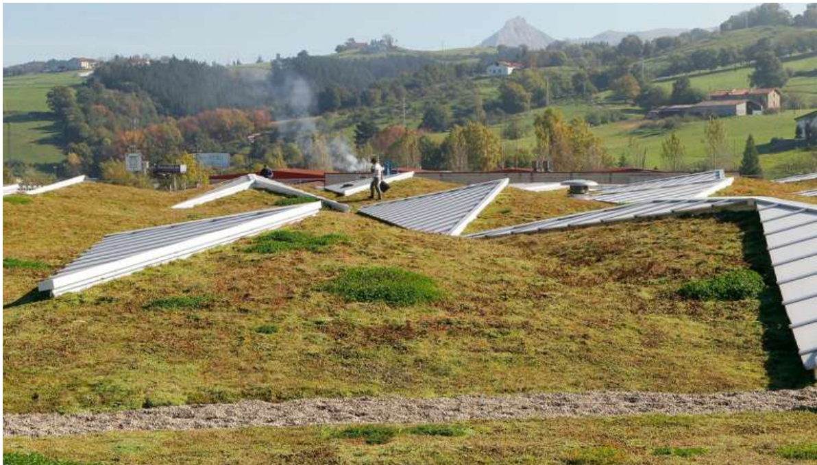
Fig. 28. Cubierta verde en una nave de mecanizado industrial de Ampo, Idiazabal, Guipúzcoa. Fuente: https://www.interempresas.net/Instaladores/Articulos/213156-Knauf-Insulation-instala-una-cubierta-verde-de-6800m2-en-Guipuzcoa.html
