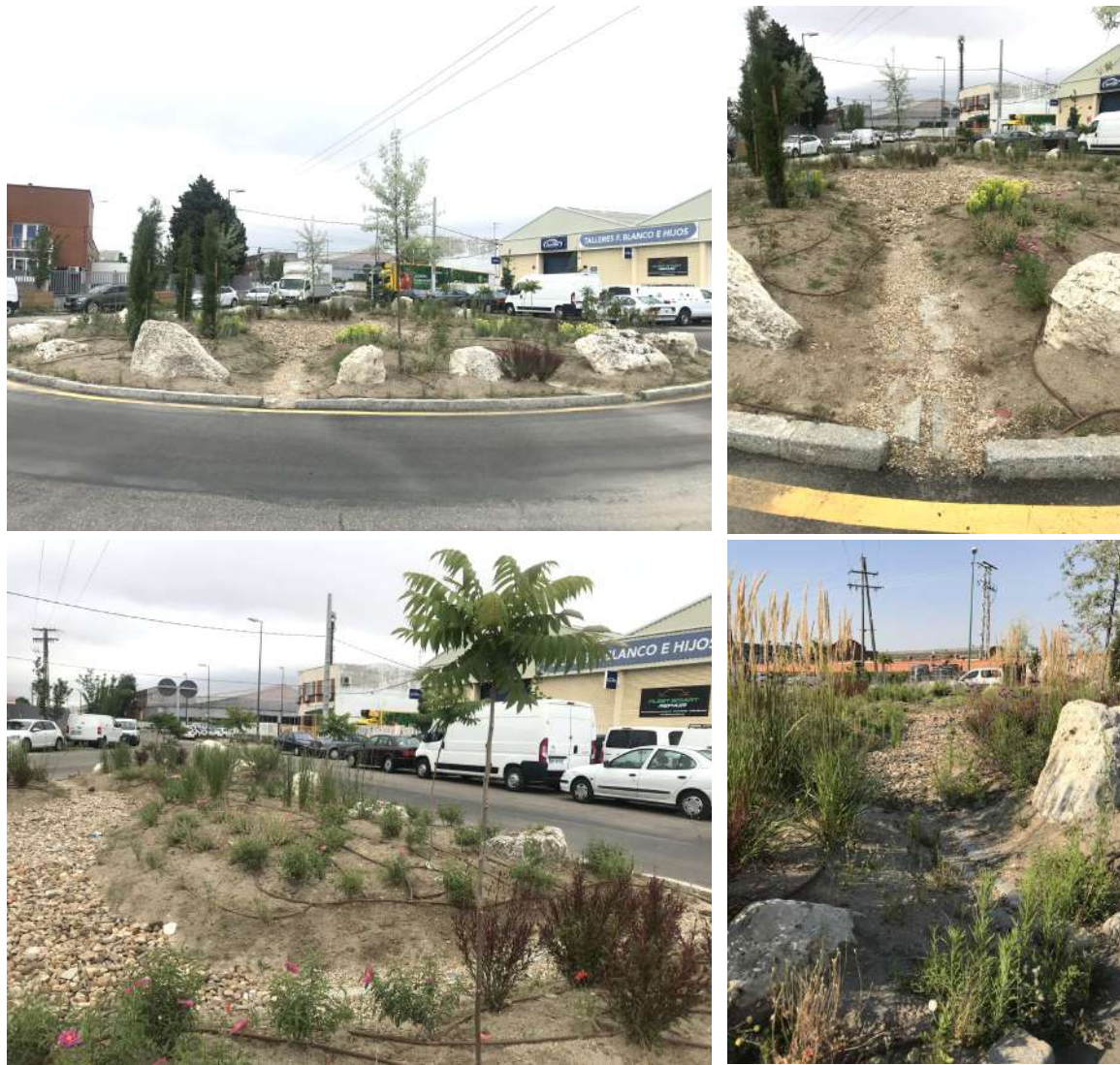
Fig. 17, 18, 19 y 20. Jardín de lluvia construido en la rotonda de la calle Pilar Miró del polígono de Argales. Fuente: M. Rosario del Caz Enjuto (UVa).
