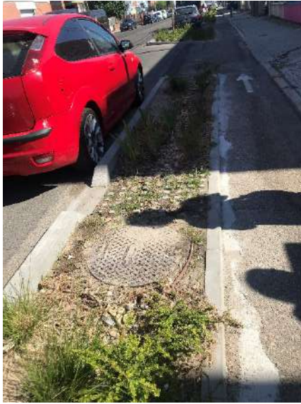
Fig. 51: Intervención en la avenida Norte de Castilla. Especies ornamentales en cuneta verde con el sustrato M1 (26-07-22).
