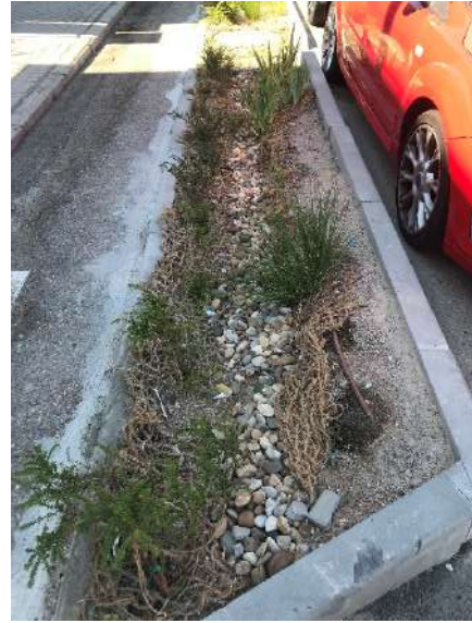
Fig. 52: Intervención en la avenida Norte de Castilla. Especies ornamentales en cuneta verde con los sustratos M2 y M3 (26-07-22).
