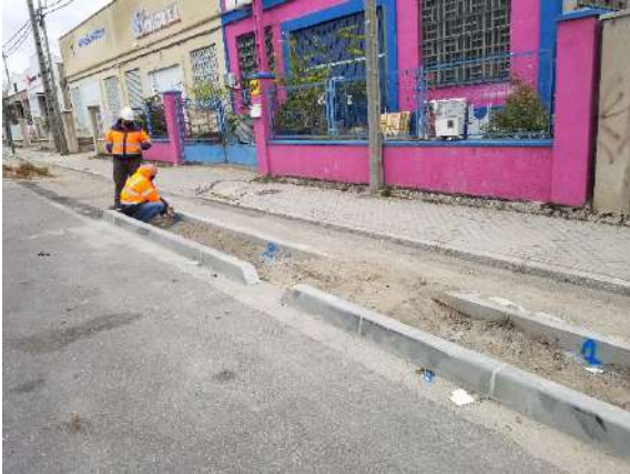
Fig. 44: Intervención en la avenida Norte de Castilla. Marcaje de los puntos para la aplicación de los distintos sustratos.
