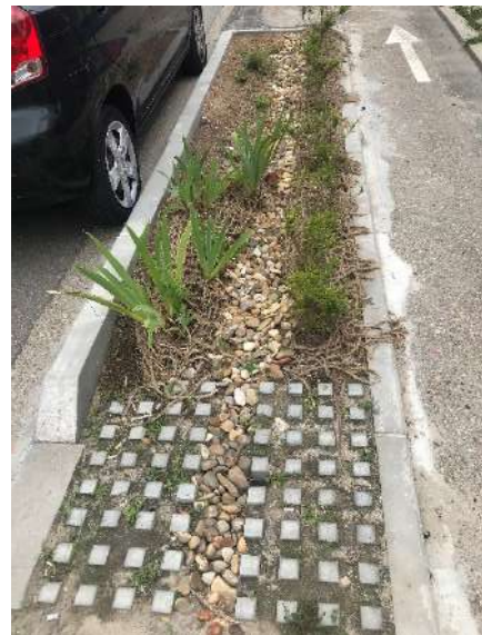
Fig. 47: Intervención en la avenida Norte de Castilla. Especies ornamentales en cuneta verde con los sustratos M2 y M3 (23-05-22).
