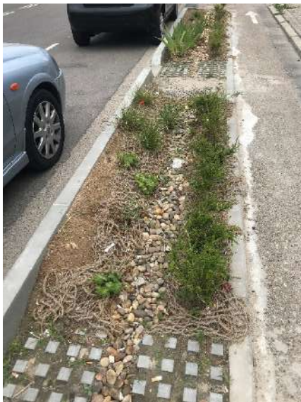
Fig. 46: Intervención en la avenida Norte de Castilla. Especies ornamentales en cuneta verde con el sustrato M1 (23-05-22).
