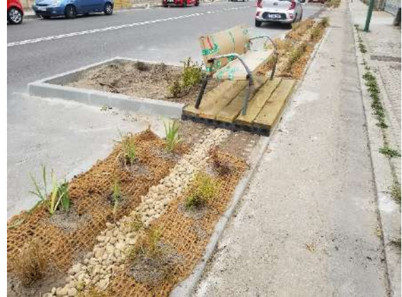
Fig. 45: Intervención en la avenida Norte de Castilla. Ejecución de la cuneta verde.
